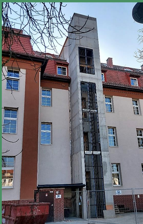
W trakcie realizacji:
